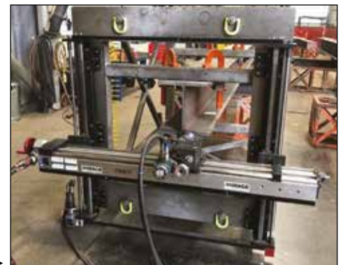
Fraisage de l'extrémité d'une poutre en I à l'aide d'un kit GMRF1000. ►
