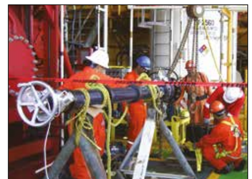
▼ Utilisation de la machine de piquage en charge CHT2000 en mer.
