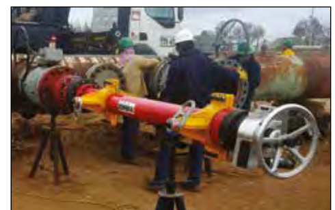
▲ Foratura tubi con CHT3000 per l'installazione di condotte petrolchimiche.
