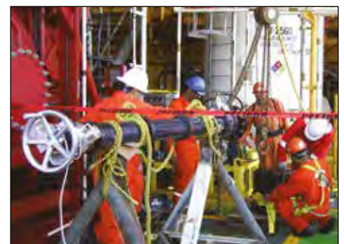
▼ Foratura tubi con CHT2000 per applicazioni offshore.
