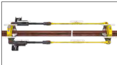
▲ La tensione modulare da 70 tonnellate, mantiene la rotaia in posizione neutra durante il processo di saldatura.
