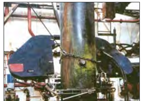
▼ Lavoro di smantellamento con sega a nastro.
