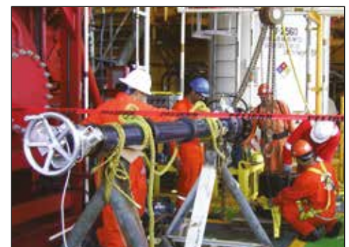
▼ CHT2000 Hot-Tapping-Offshore-Anwendung.
