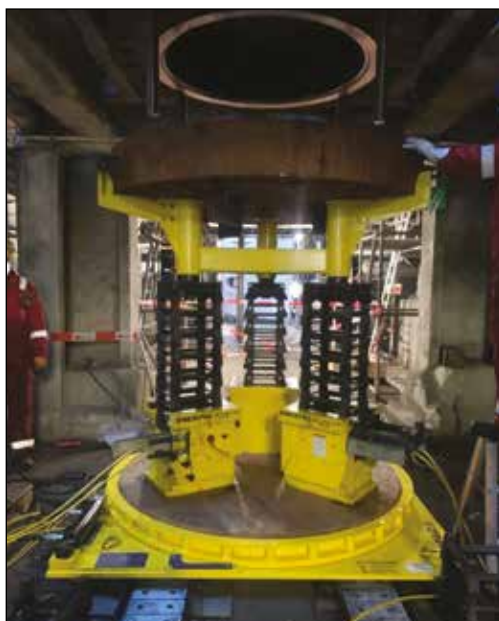
◀ Wärmeaustauscher-Wartung an Rohrleitungen und Kondensatoren einer Raffinerie mithilfe einer Kombination von Enerpac Heavy Lifting Technology: Cube Jacks der SCJ-Serie, hydraulische Drehteller der ETT-Serie und Low-Height-Gleitsysteme der LH-Serie.
